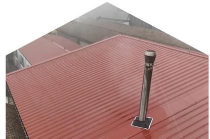
Réfection de toiture sur différents bâtiments du site avec des matériaux adéquats au taux d'acidité des vapeurs alcooliques : revêtement spécial pour une atmosphère corrosive
