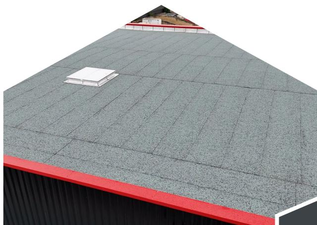
Couverture multicouches destinée à recevoir des panneaux photovoltaïques.
